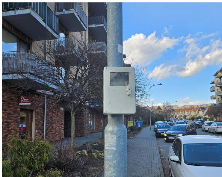
Obr. 23 Kamera v ochranném krytu připevněna na sloupu veřejného osvětlení (zdroj: BKOM)
