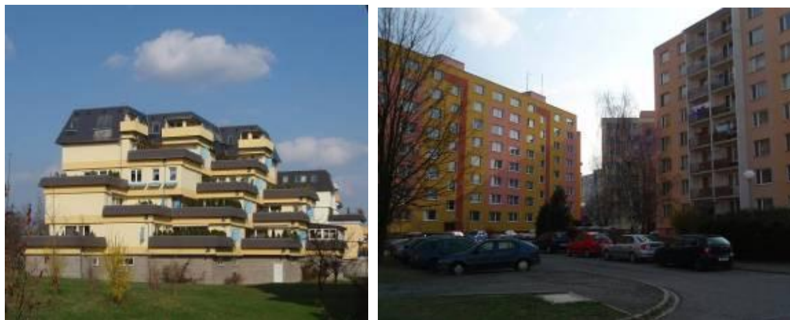
Obr. 10 Kaskádový styl bytové zástavby na Tabulovém vrchu (vlevo), sídliště na Lazcích (vpravo).
