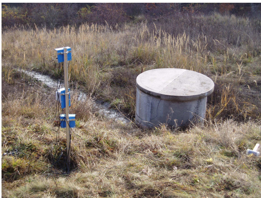
Obr 2.: Stanice ALA s průtokoměrem
