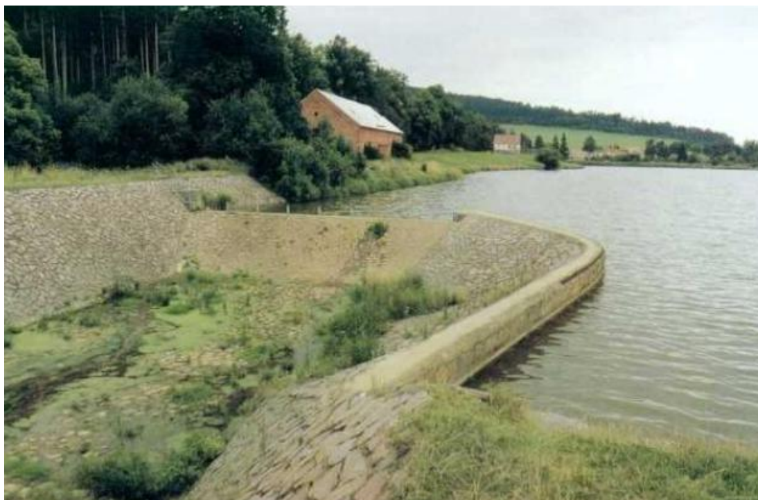
Obr. 2: VD Moravská Třebová (Zdroj: Průběh zvláštní povodně v Třebůvce pod VD Moravská Třebová, 2011)
